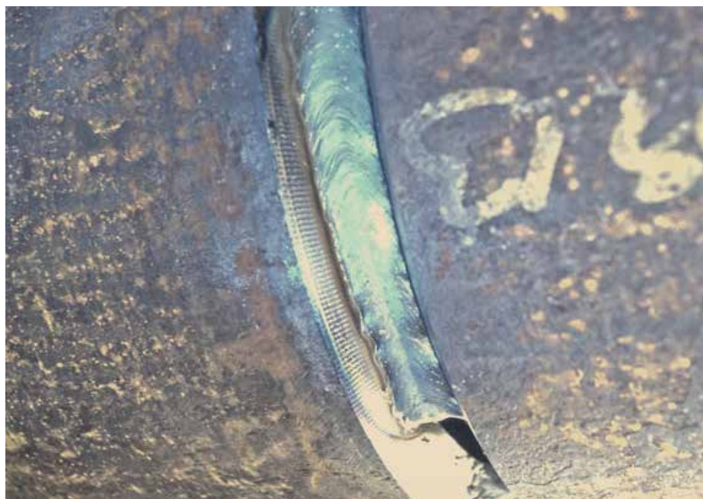
IAC™ - Saldatura verticale discendente delle passate di radice in un tubo per teleriscaldamento. La velocità di saldatura è decisamente aumentata rispetto alla saldatura ascendente tradizionale.
